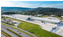
4 CORTIZO COIRÓS CENTRO DE RECICLAJE RECYCLING CENTRE
